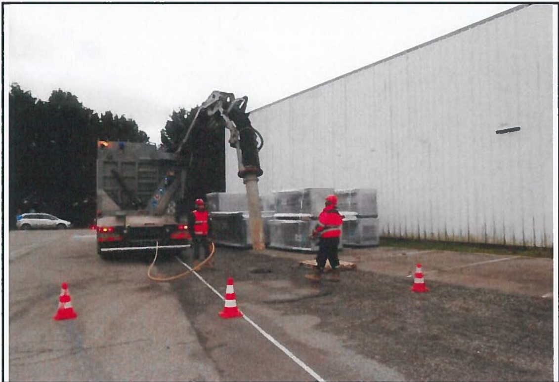
Photographie : 1 | Réalisation d'un avant-trou (MW6)
