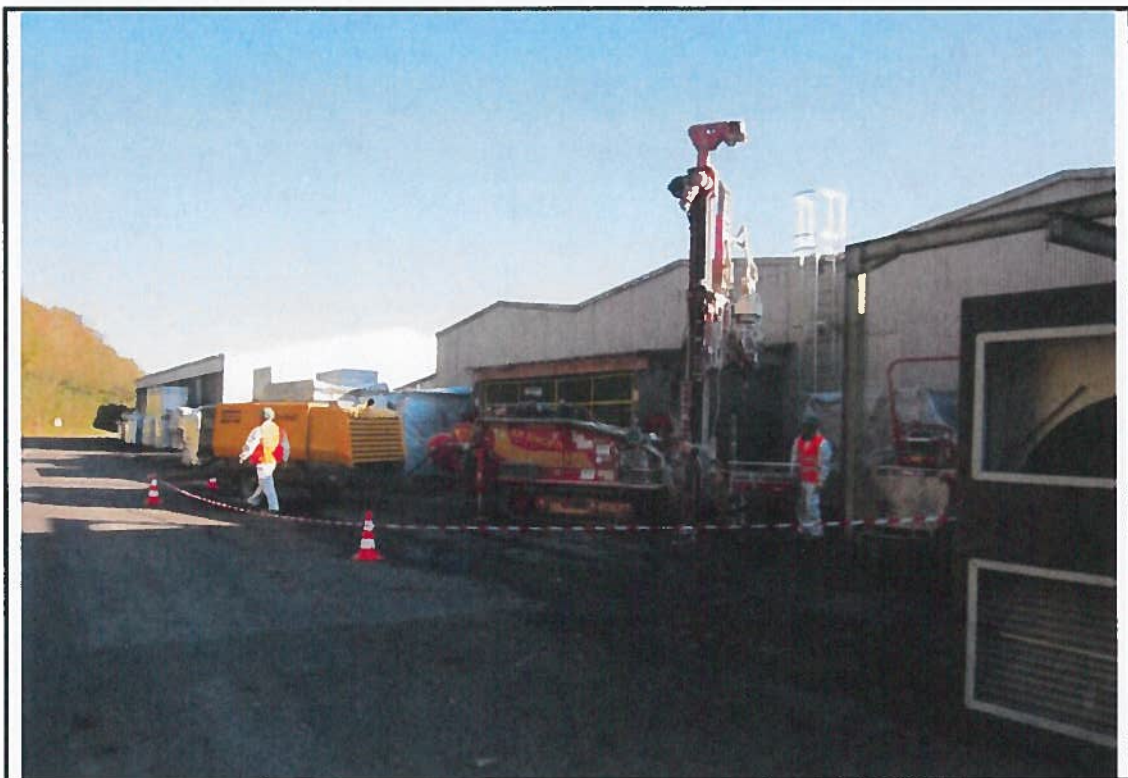
Photographie : 4 | Travaux de forage (SB5/MW1)
