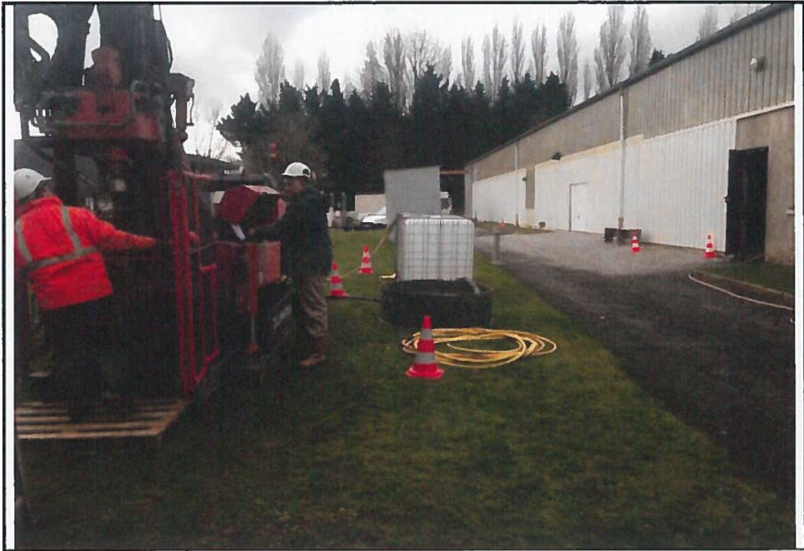
Photographie : 11 Installation de l'atelier de forage sur MW4
