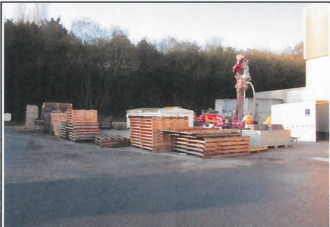
Photographie : 6 Travaux de forage (SB2)
