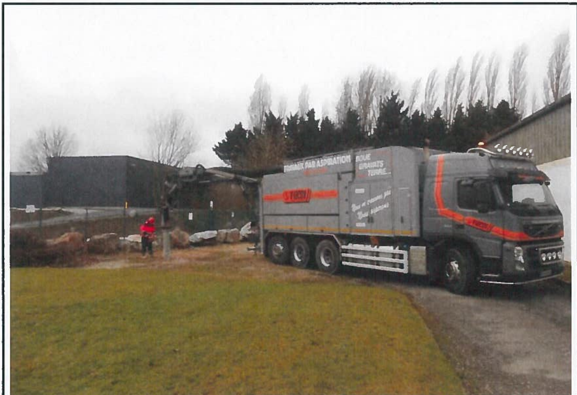
Photographie : 2 | Réalisation d'un avant-trou (MW-3).
