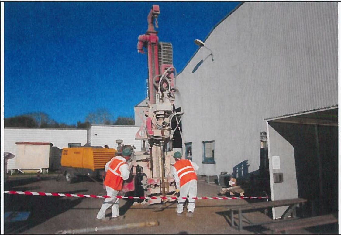
Photographie : 5 Travaux de forage (SB1)
