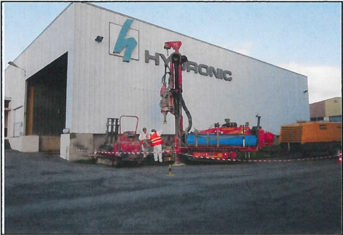
Photographie : 7 | Travaux de forage (SB4/MW10)
